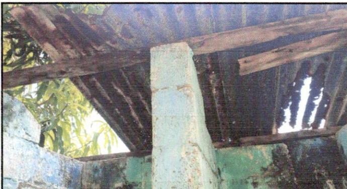
Foto 3: sustitución de lamina por lamina troquelada calibre 26, sustitución de soporte de madera por metal *MODULO SANITARIO*
